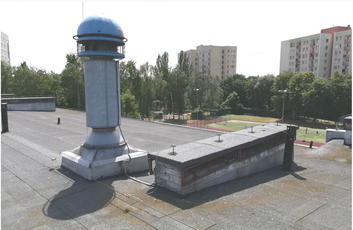
Kominy wentylacji grawitacyjnej oraz istn. wentylator wyciągowy dla kuchni.
