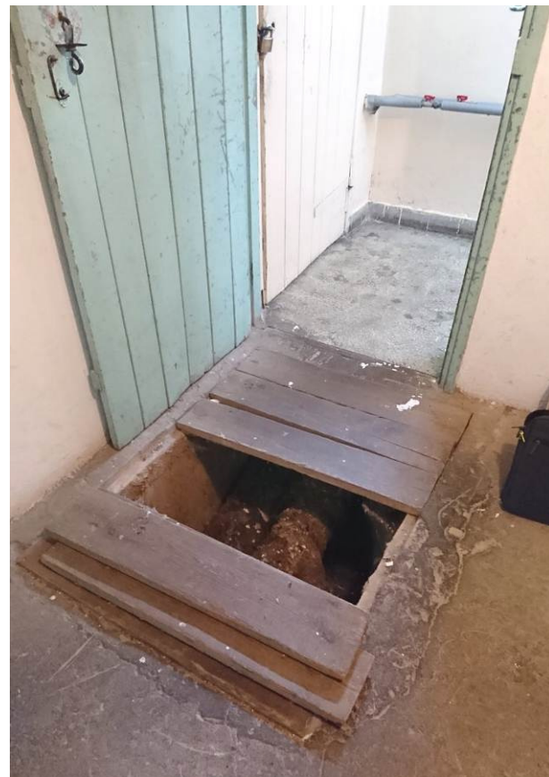
Studzienka z zaworem burzowym w piwnicy.
